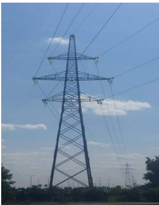
Slika 1.2-1: Dvostruko čelično-rešetkasti stup, oblik "bačva"
