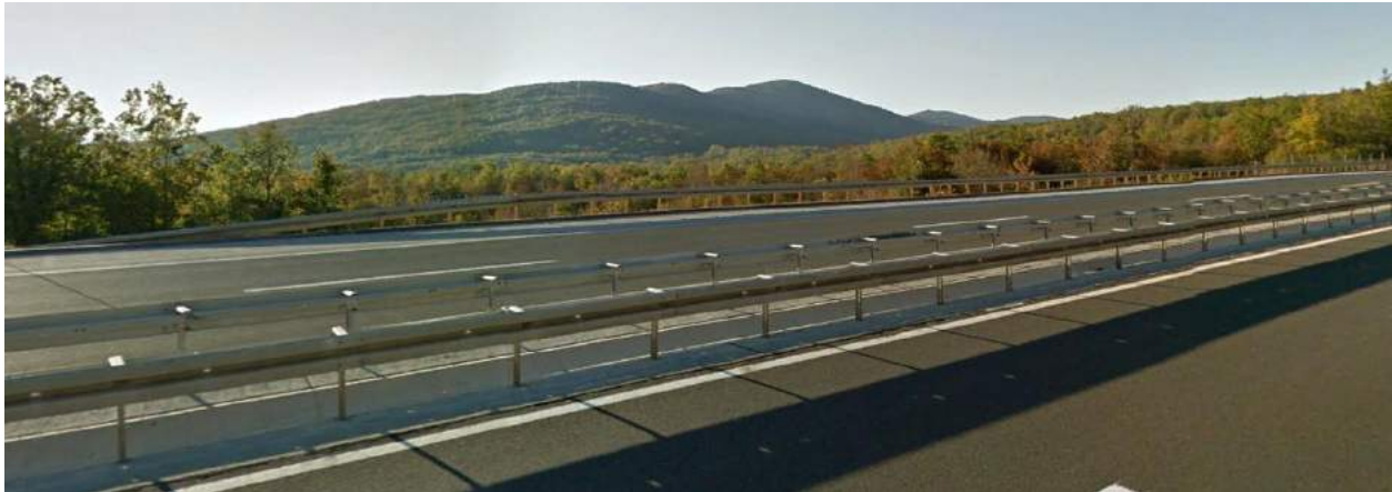
Slika 2.1-1: Pogled na uzvisnu Jelovača i postojeće dalekovode 110 kV Otočac – Lički Osik i 220 kV Konjsko – Brinje s autoceste A1, ~1300 m udaljenosti. Izvor: Google Earth
