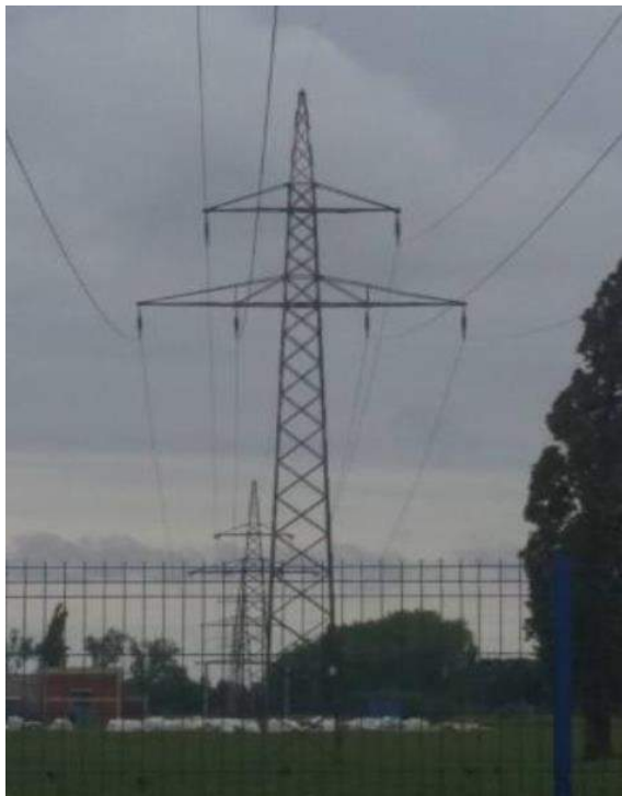
Slika 1.2-2: Dvostruko čelično-rešetkasti stup, oblik "Dunav"
