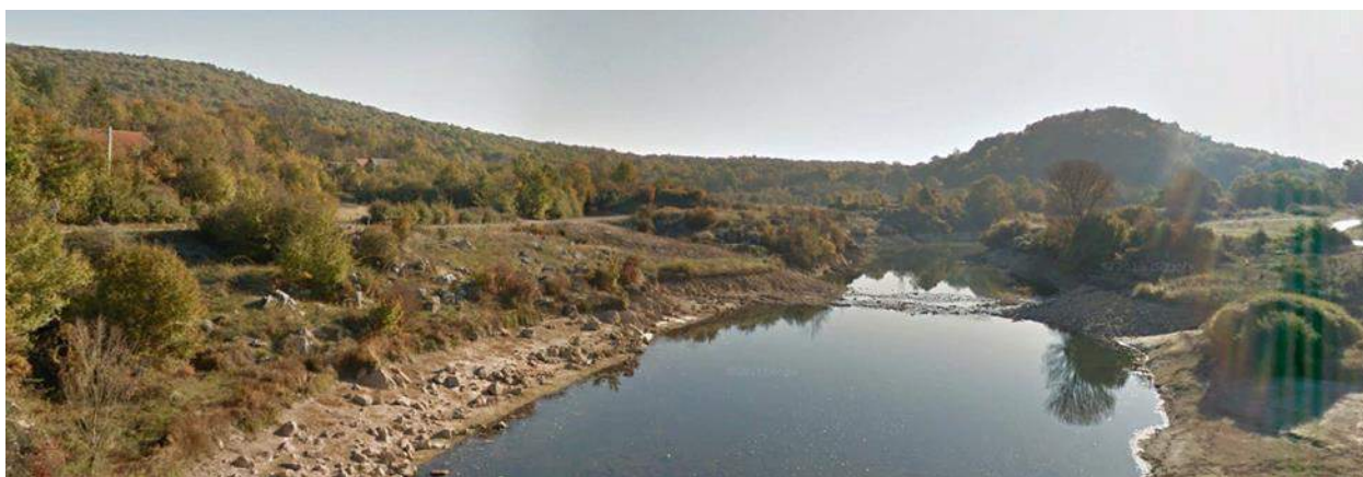
Slika 1.7-9: Pogled na uzvisinu Vršak (označeno strelicom) s Kosinjskog mosta.
